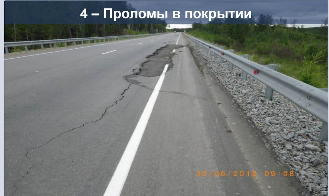
Полное разрушение дорожной одежды на всю ее толщину с резким искажением поперечного профиля, сопровождающееся сеткой трещин.
