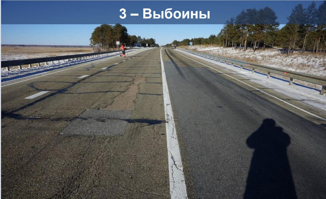
Разрушение покрытия в виде углублений разной формы с резко выраженными краями (более 3 см глубиной и 200 кв. см по площади) .
